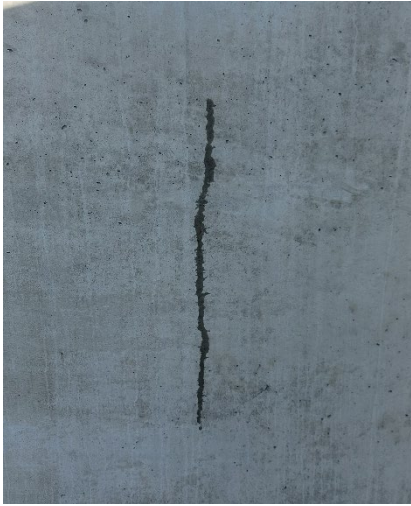
Bug hole/fibre weeping
